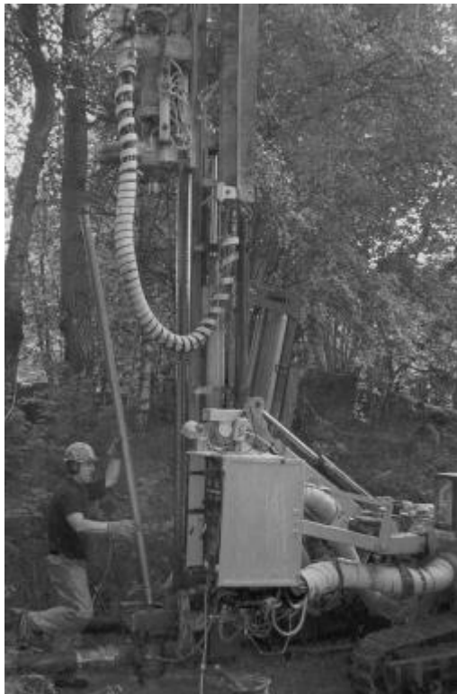
Åtskilliga rör får skarvas på för att nå 123 meters djup.
