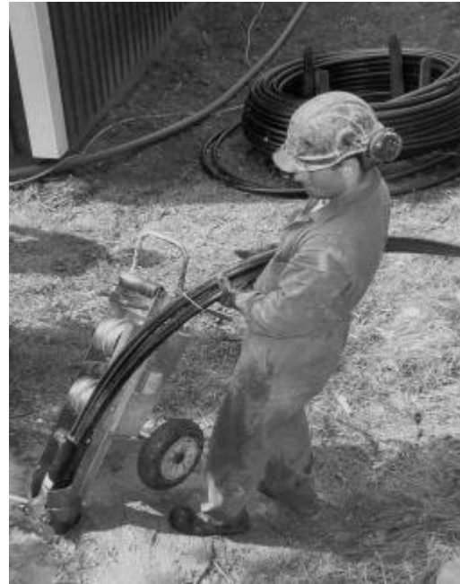
Slangen matas ned i borrhålet.
