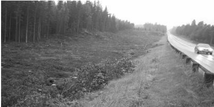
Röjning av skog vid norra anslutningen
